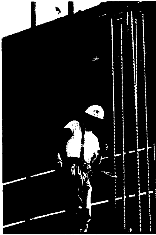
Obreros de la construcción sobre andamios
