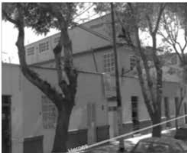
Imagen 3. Ampliación de una vivienda en la calle Héroes, colonia Doctores. Fuente: Google Maps, consultado en marzo, 2015.
